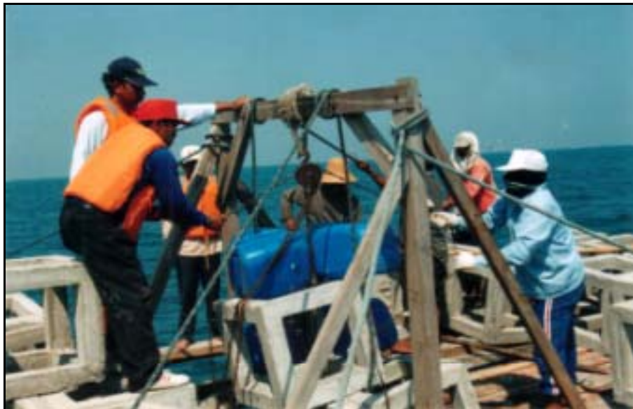
Pemasangan Terumbu Karang Buatan
