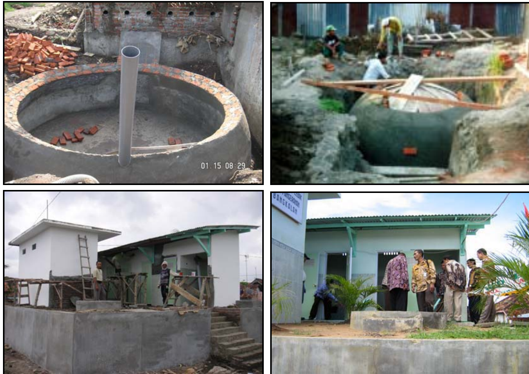
Proyek Pembangunan Sanitasi oleh PROGRAM SANIMAS
